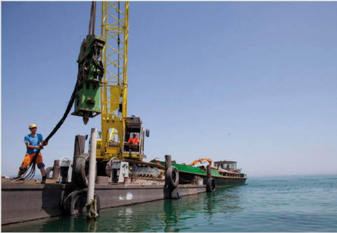
Stahlpfähle rammen ab Ponton
