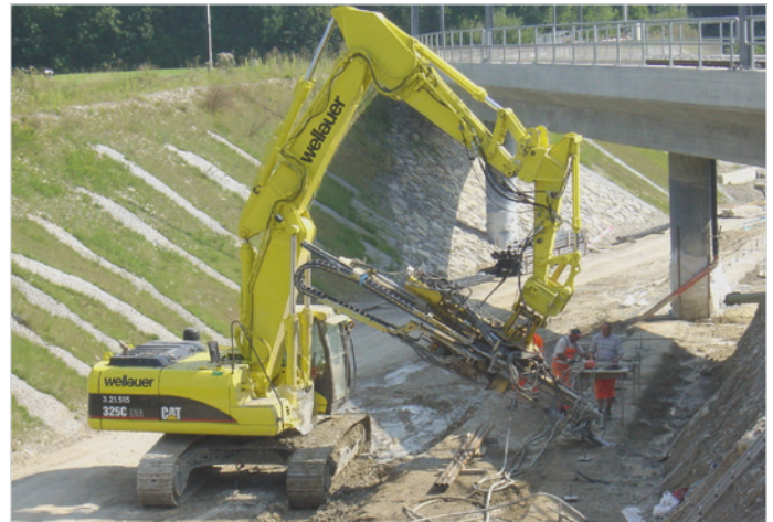
Hydraulikbagger mit Anbaulafette
